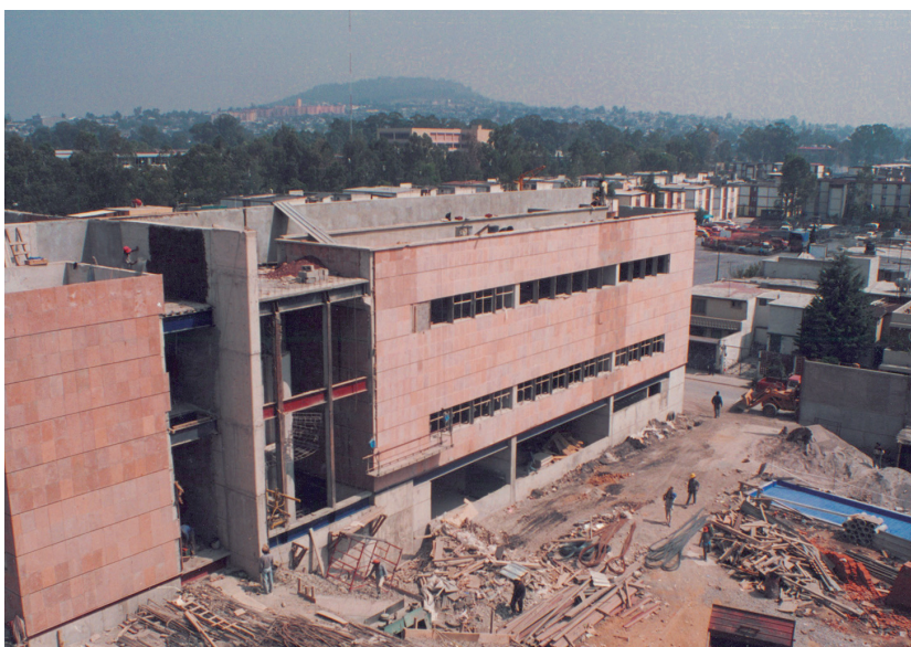
Construcción del edificio principal de la Sala Superior del Tribunal Electoral del Poder Judicial de la Federación, 1993.
